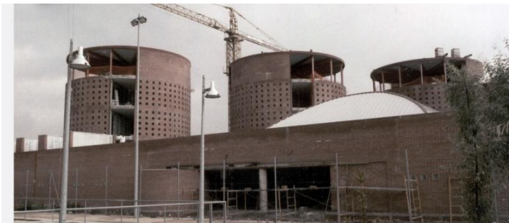
Les tres torres, en construcció
